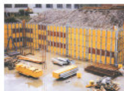
piccoli cantieri edili
