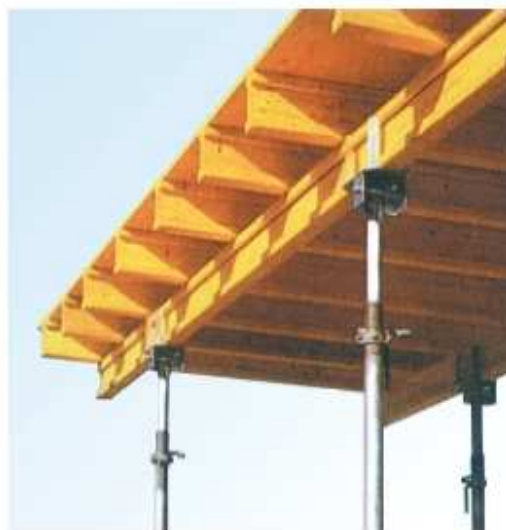
armatura per solaio pieno in calcestruzzo
