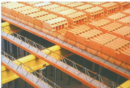
uso como rompe-tramo en encofrado portante
