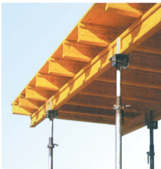
armazón para encofrado horizontal en hormigón
